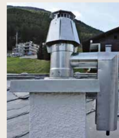
Eine Elektrode im Schornstein entfernt nachweislich bis zu 90 % des Feinstaubes aus dem Abgas – mit Hilfe des elektrostatischen Prinzips.
